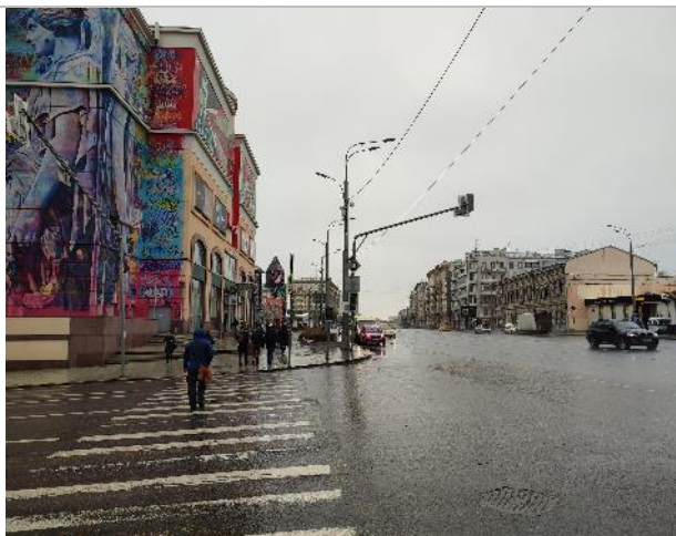
Фотография 8. Подъездные пути и фасад здания.
