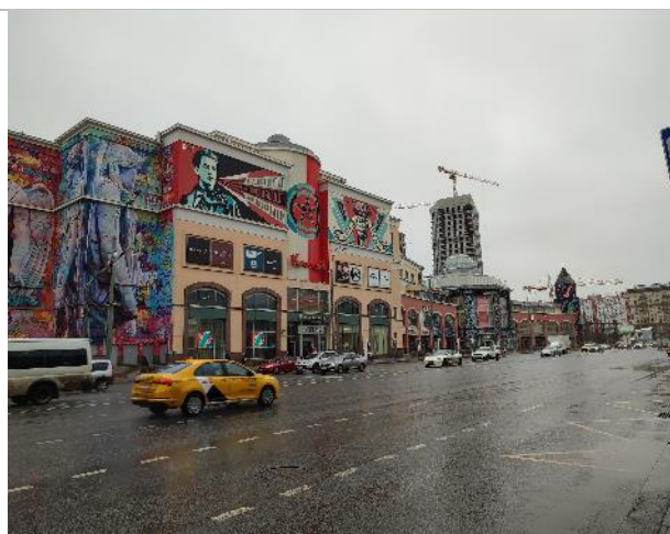
Фотография 4. Подъездные пути и фасад здания.
