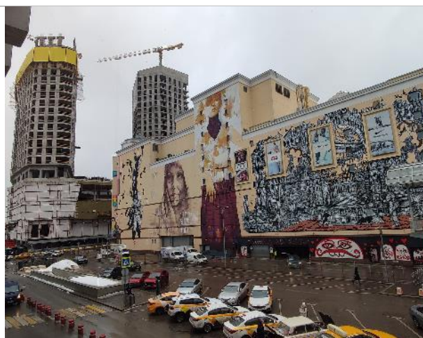
Фотография 16. Подъездные пути и фасад здания.
