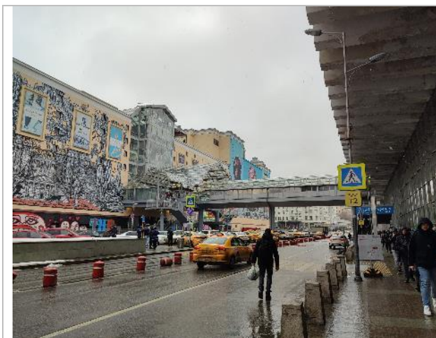
Фотография 19. Подъездные пути и фасад здания.
