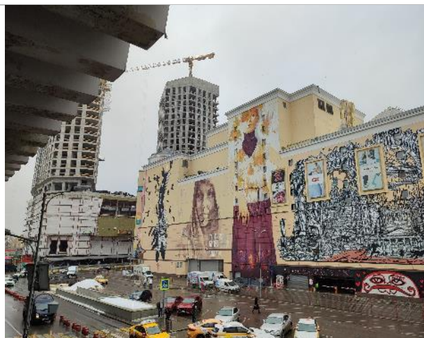
Фотография 18. Подъездные пути и фасад здания.
