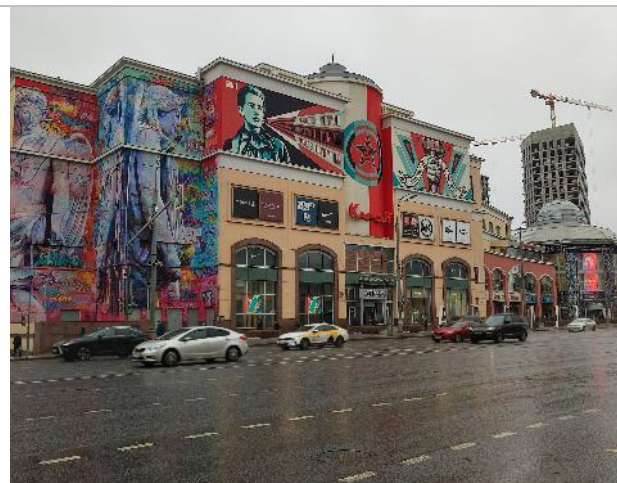
Фотография 1. Подъездные пути и фасад здания.
