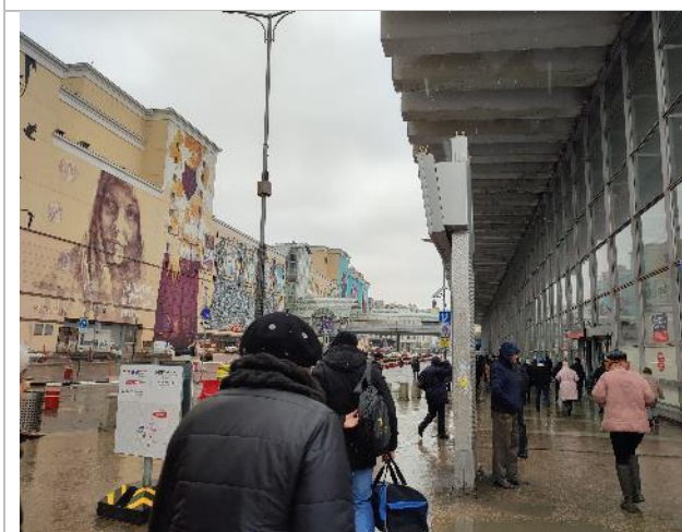
Фотография 21. Подъездные пути и фасад здания.
