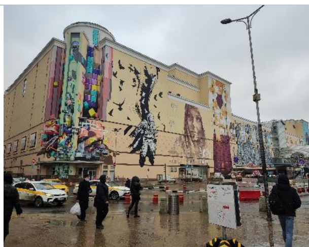
Фотография 24. Подъездные пути и фасад здания.
