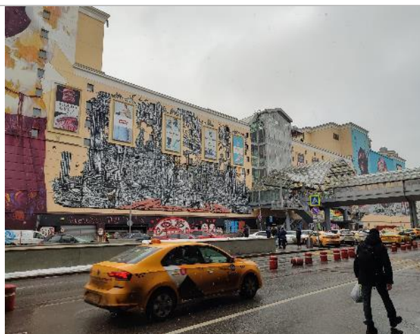
Фотография 20. Подъездные пути и фасад здания.
